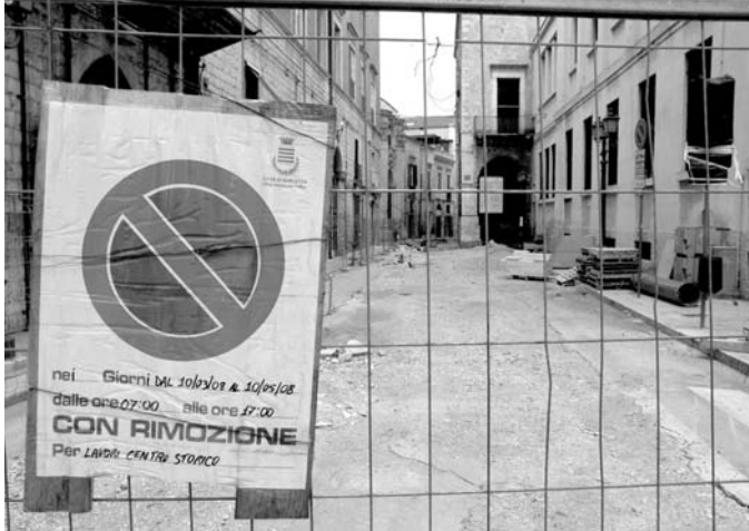
Barletta, il cantiere in corso Garibaldi [foto Calvaresi]
